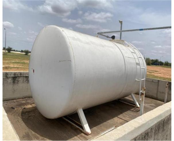
**Photo 6: Aire de stockage d'une cuve à gasoil d'une capacité de 10 m3, EDE-SEGU, Juillet 2024**
